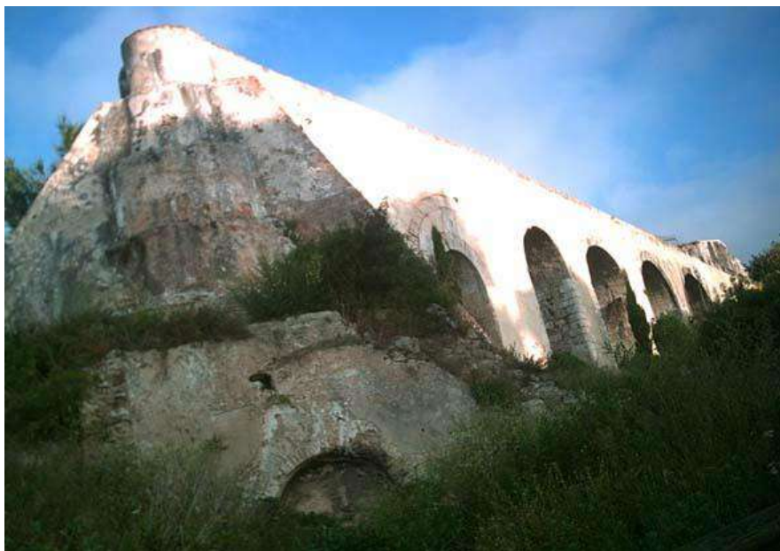
Molinos y acueducto de Santa Lucía, próximos a la Fuente.
