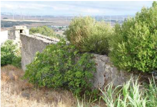
Imagen de la acequia de alimentación del molino.
